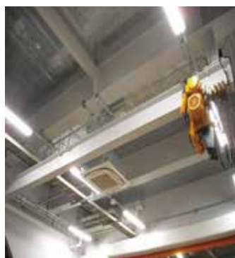
東罐興業(株) 茨城工場 (荷捌き場)
